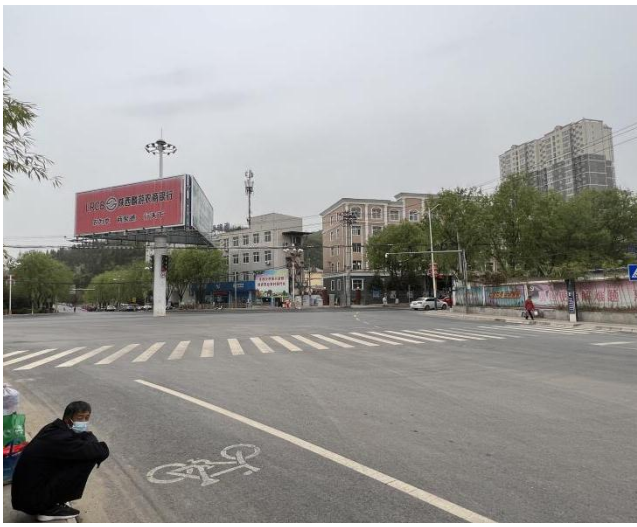
项目起点 (K0+000) (2022年6月)
