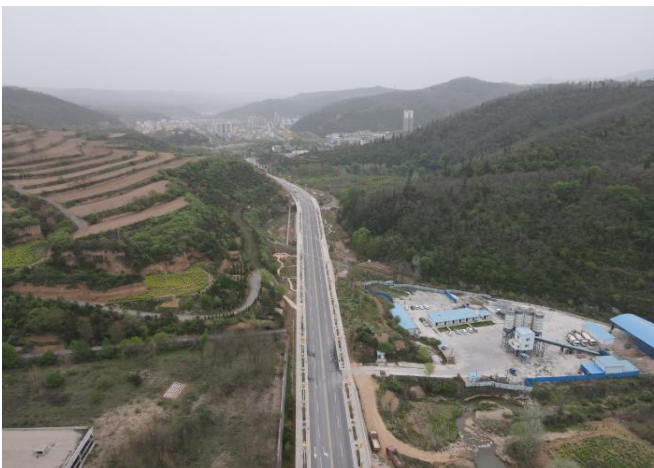
沿线航拍图 (2022年6月)
