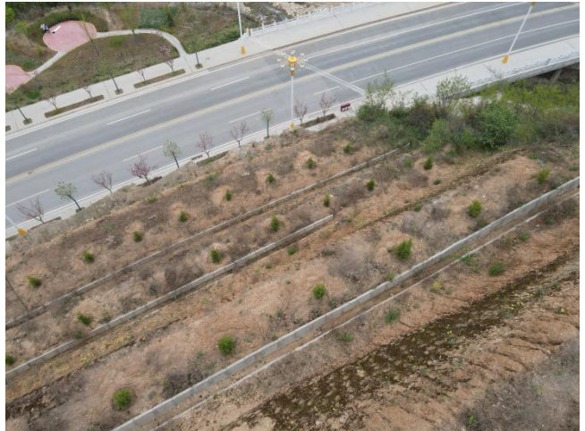
高开挖边坡截水沟 (K0+679) (2022年6月)
