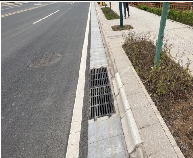
路基排水工程 (K2+234) (2022年6月)
