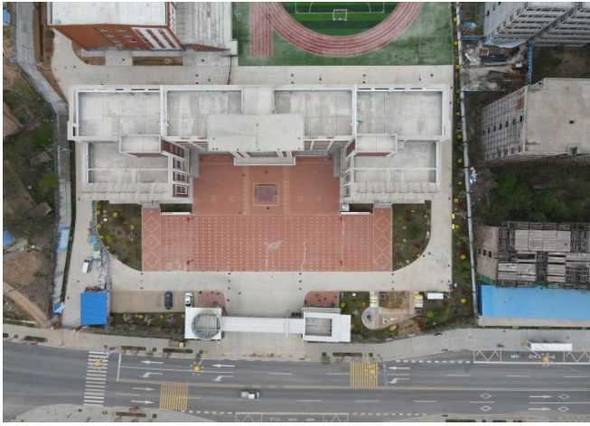
2#施工营地 (K1+470) (2022年6月)
