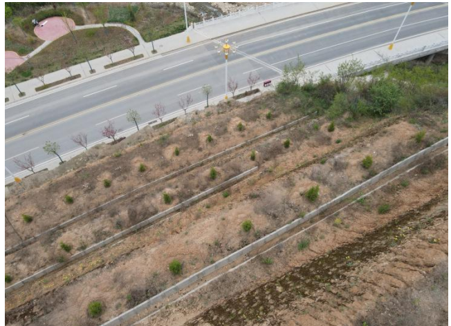
高开挖边坡截水沟 (K0+679) (2022年6月)
