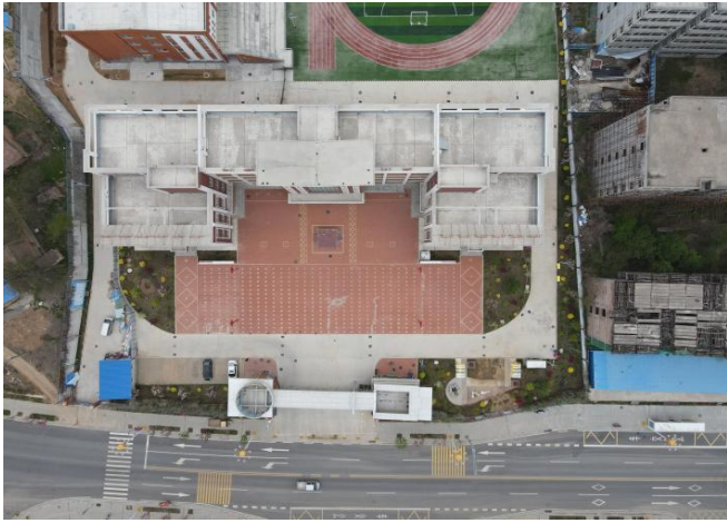
2#施工营地 (K1+470) (2022年6月)
