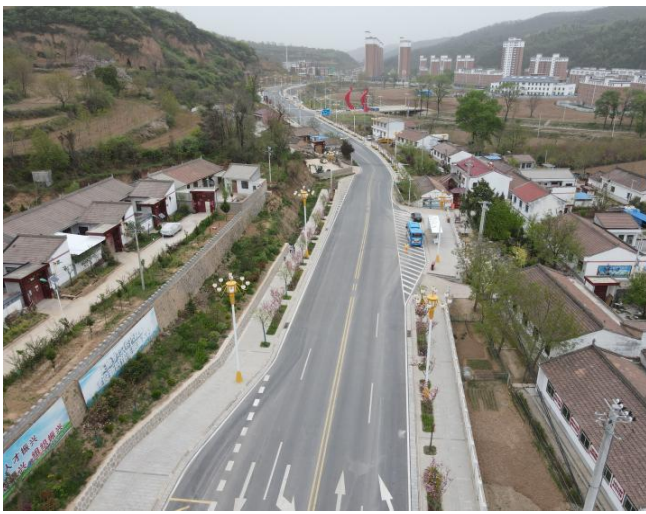
路基航拍图 (K2+186) (2022年6月)
