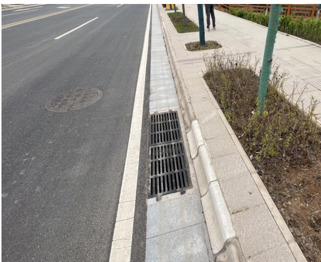
路基排水工程 (K2+234) (2022年6月)
