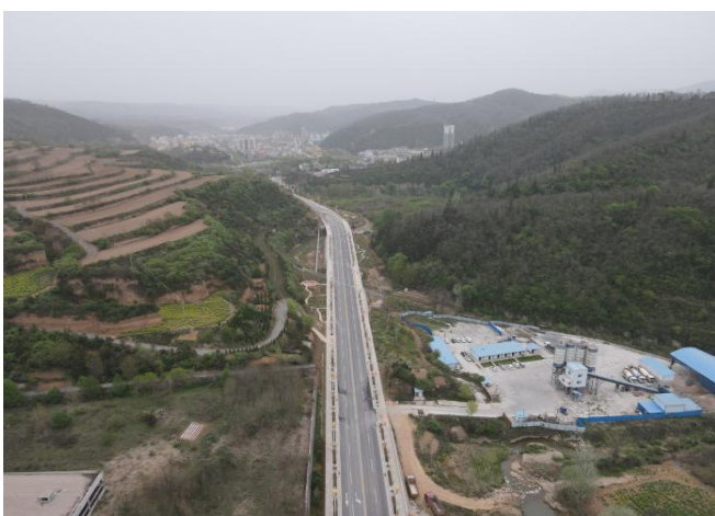
沿线航拍图 (2022年6月)
