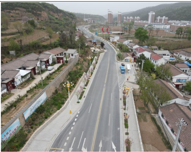
路基航拍图 (K2+186) (2022年6月)
