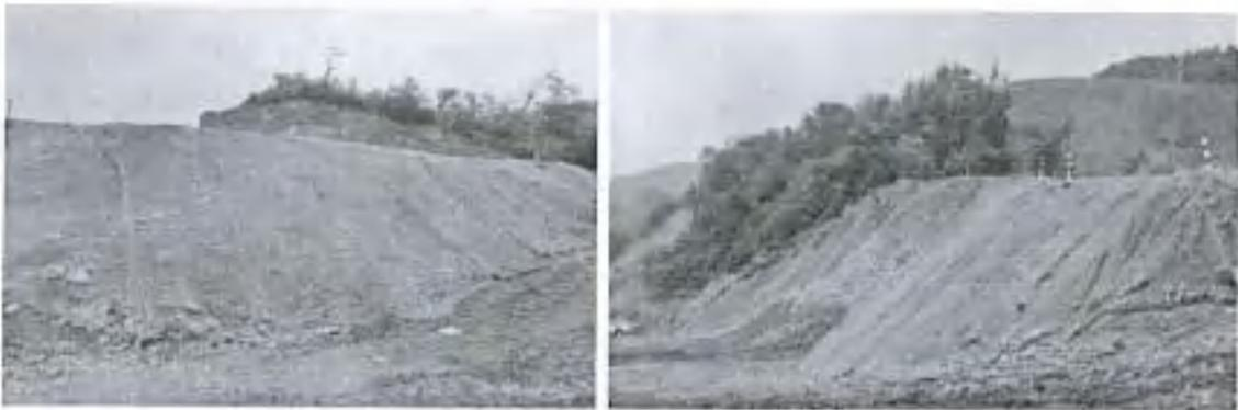
施工现场临时防护、坡面遮盖防尘网
