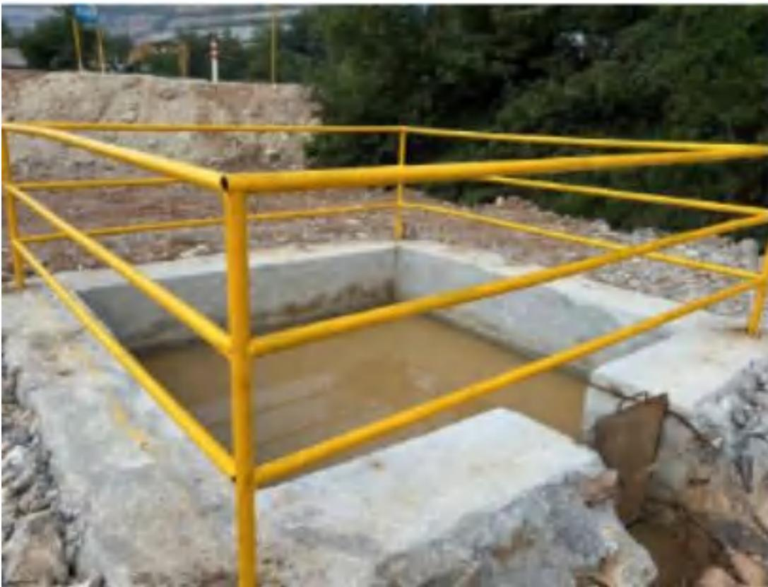
图6-3制作临时沉沙池、雨水沉淀池
