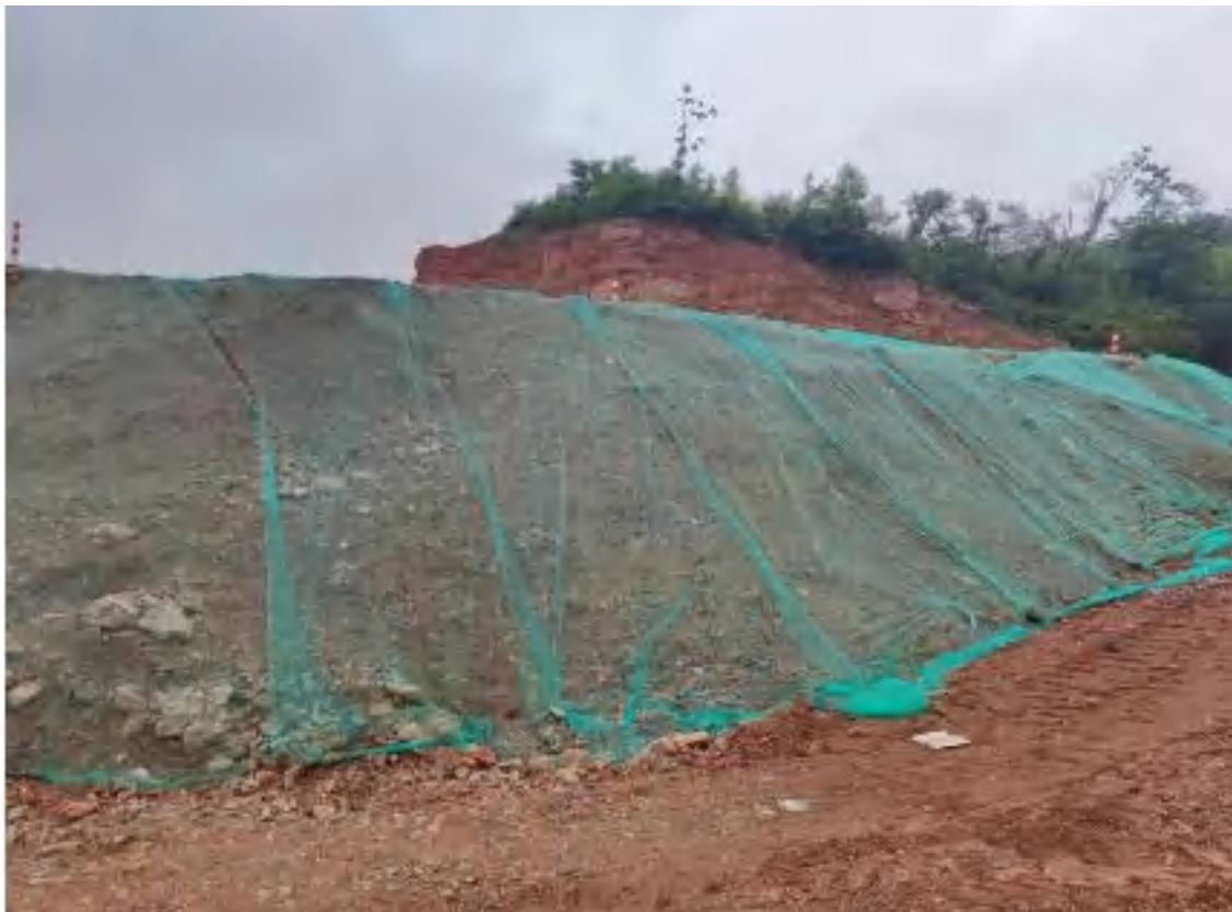
图6-1施工现场增加临时防护、坡面遮盖防尘网
