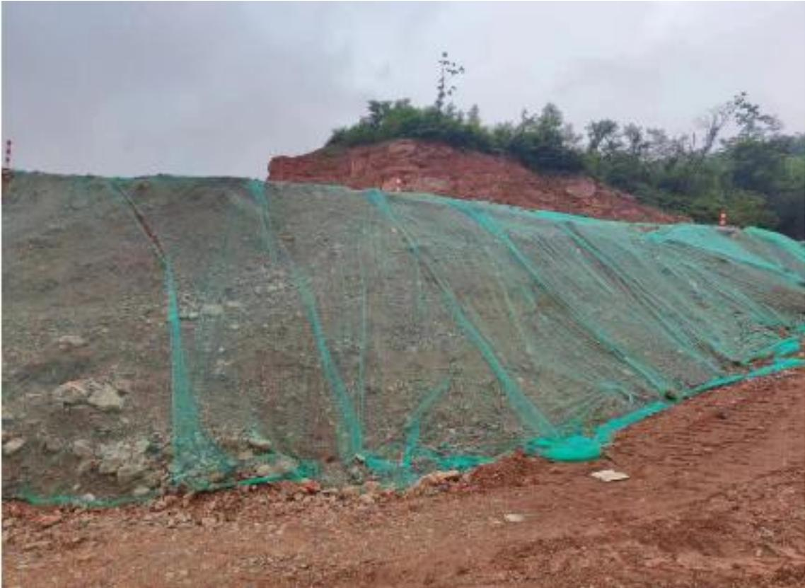
图1-1施工现场增加临时防护、坡面遮盖防尘网
