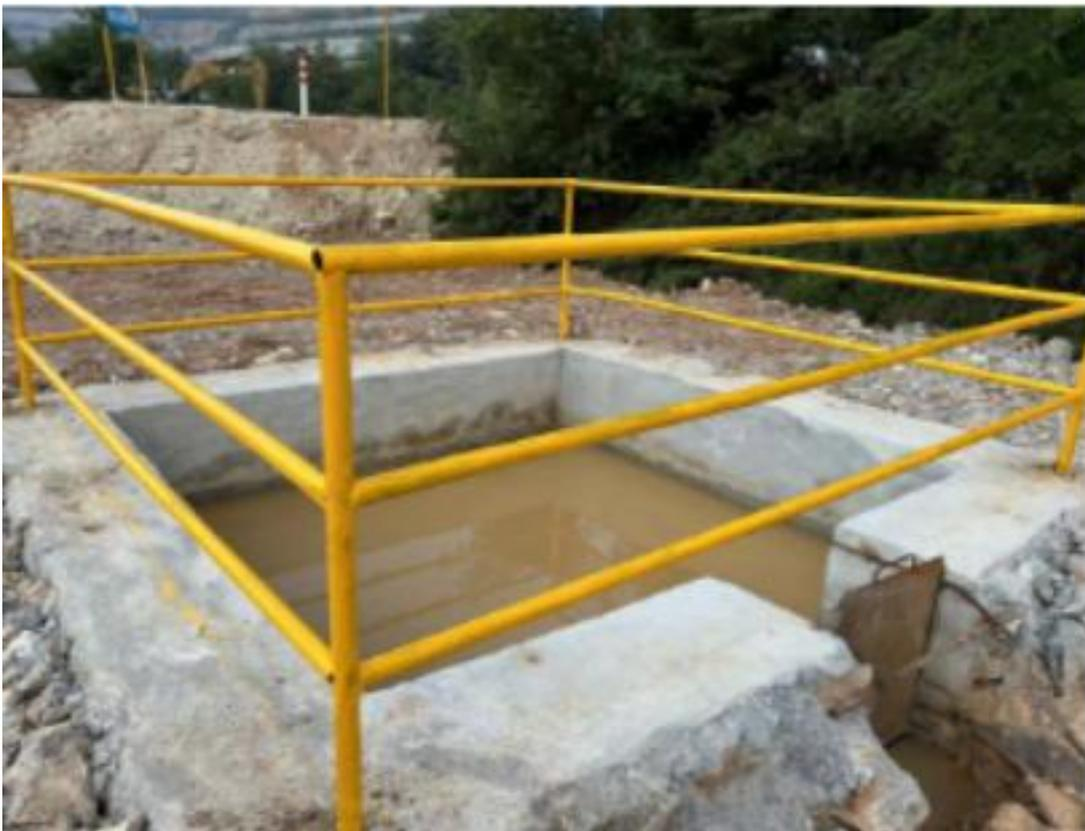
图1-3制作临时沉沙池、雨水沉淀池
