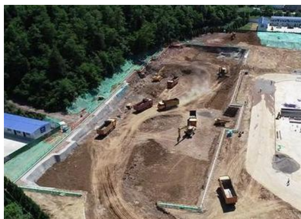
麟游县官坪新区建设项目土方回填
