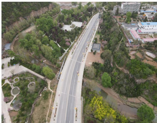
桥梁工程区 (K0+490) (2022年6月)
