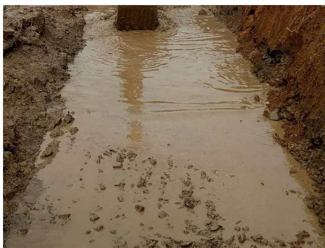
临时排水沟 (K0+752) (2018年7月)
